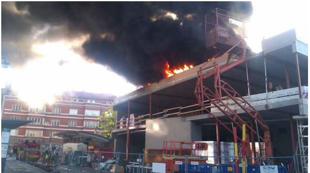
Figur 19 Takbrand i byggprojekt i Lund. Foto Rikard Willman, läsbild från Sydsvenskan. Källa: http://www.sydsvenskan.se/lund/haftig-takbrand-i-saluhallen/
