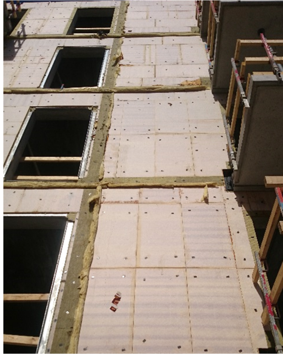
Figur 24 Prefabricerad halv-sandwichvägg med exponerad cellplastisolering, före fasadmontage. I detta exempel används PF-isolering med Euroklass C-s1,d0, och konstruktionen är SP Fire 105-godkänd även utan beklädnad [41]. Brandrisken i produktion har alltså sänkts genom materialval istället för konstruktionsval. Foto: Magnus Wallin, Kingspan
