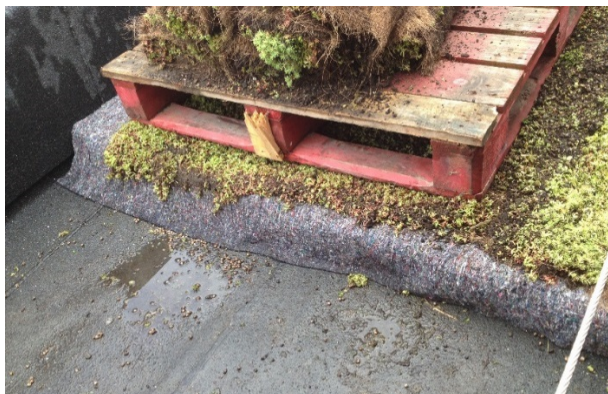
Figur 25 Exempel på en terrasskonstruktion med sedumtäckning på dränerad EPS. Vid läggningen täcks EPS:en löpande över av den fukthållande filtern och sedummattan, vilket minskar mängden exponerad EPS och risken för antändning. Foto: Skanska
