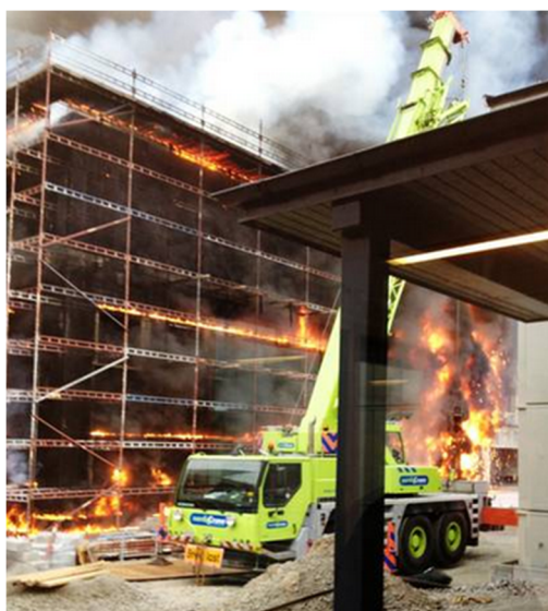
Figur 1. Brand i monterad EPS-cellplast på yttervägg under produktion (Skanska)
