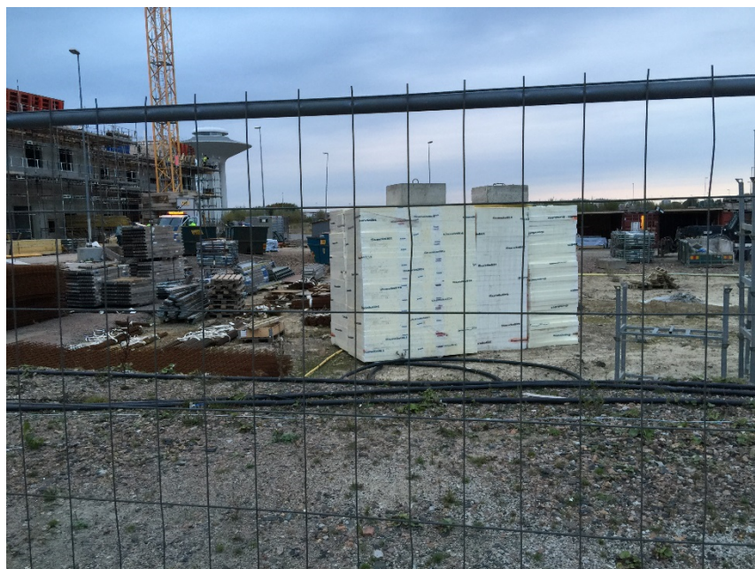
Figur 26 Mindre cellplastupplag på arbetsplats. Foto: Skanska
