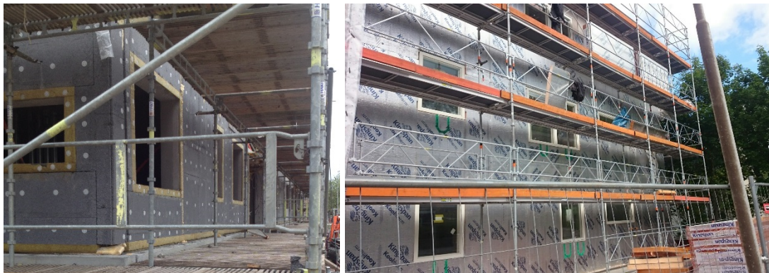
Figur 15 Exempel på utvändigt isolerade halvsandwichväggar med olika cellplaster. Tv användning av grafit-EPS med brandsektionering av mineralull kring fönster och i bjälklagskant. Th PF-isolering med ytskikt av aluminium. Foto: Skanska respektive Kingspan
