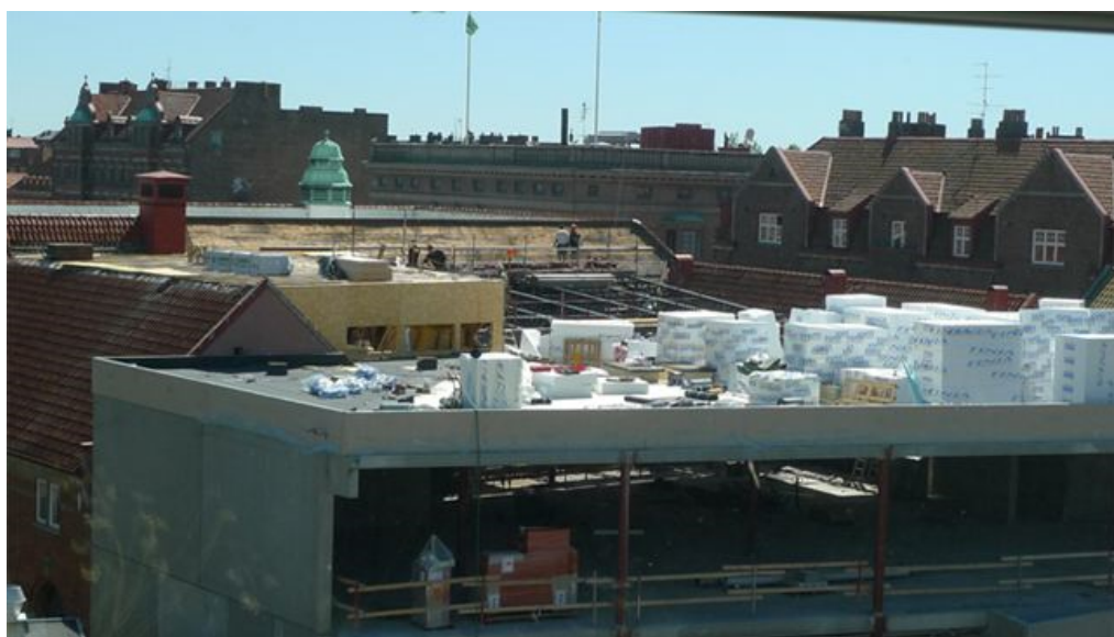
Figur 23 Cellplastupplag på tak som fattade eld vid olycka i Lund 2011. Foto Elisabeth Palm-Castorina, läsbild från Sydsvenskan. Källa: http://www.sydsvenskan.se/lund/haftig-takbrand-i-saluhallen/
